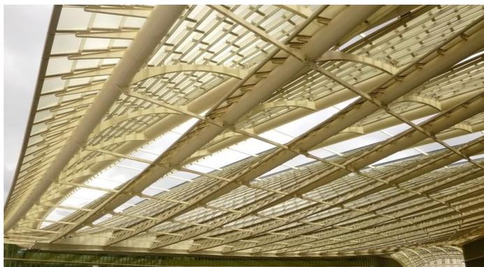
Aujourd'hui, après cinq ans de travaux, nous avons sous les yeux un fouillis de côtelettes métalliques culminant à 14 mètres de haut et supportant 18 000 écailles de verre, le tout emballé sur 25 000 m<sup>2</sup> pour un poids de 7 000 tonnes, l'équivalent d'une tour Eiffel ondulant en montagnes russes à l'horizontale, au demeurant d'une courbure et d'une hardiesse agréables à l'œil !
