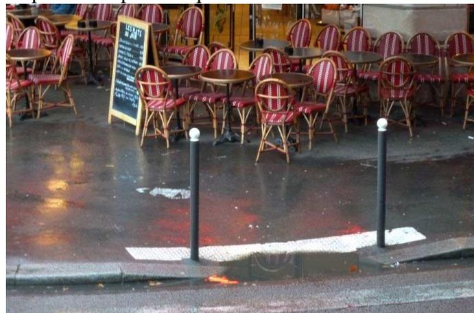
Sur les **abaissements de trottoir**, de nombreux défauts d'écoulement des eaux sont constatés au droit des passages piétons où les trottoirs ont été abaissés. Cela provient d'une exécution défectueuse des fils d'eau par les entreprises et d'un défaut de surveillance par la Ville. Une attention toute particulière est maintenant apportée par le service technique du 16<sup>e</sup>.
