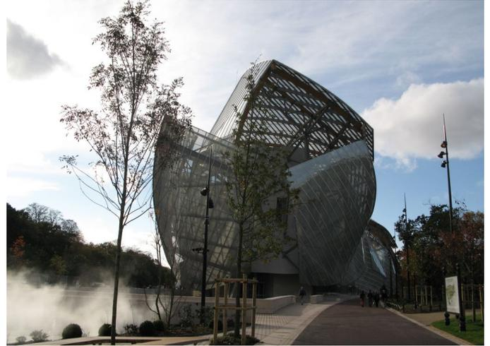
Ces immenses voiles de verre, faussement transparentes contrairement à ce qui était annoncé, culminent à 46 mètres de haut et recouvrent un enchevêtrement de poutres en bois lamellé-collé et de poutrelles d'aciers.
