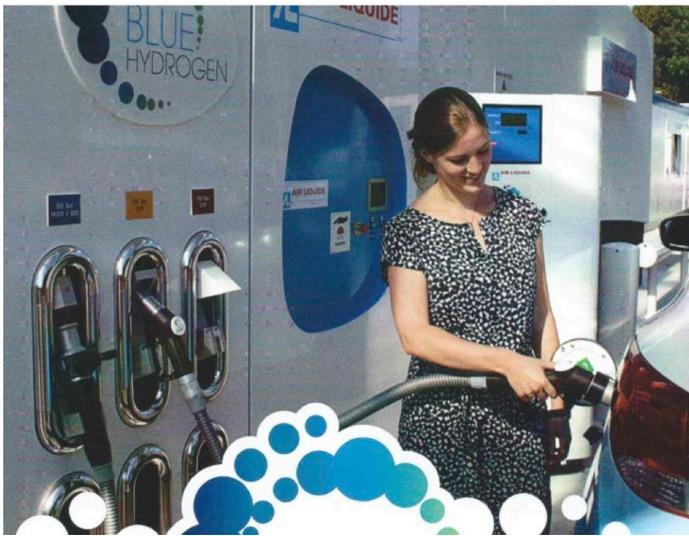
Derrière cette façade accueillante se trouve une petite usine à gaz permettant de comprimer et stocker le gaz des bonbonnes livrées à 200 bars jusqu'à 700 bars dans des cuves permettant un rechargement en moins de cinq minutes.
